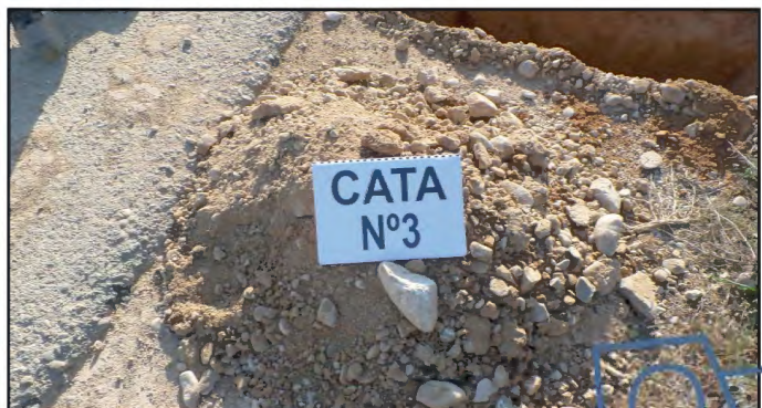
Acopio material excavado en la cata
