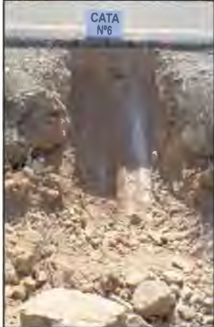
Corte natural del perfil del terreno
