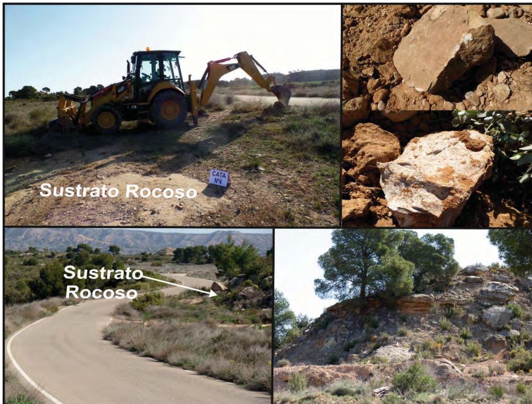
Figura 8. Detalle de afloramiento del sustrato rocoso en la parte final del recorrido del tramo de carretera estudiada. Detalle de areniscas de color gris claro extraídos de las calicatas C-4 y C-6.
