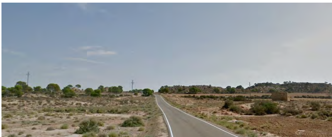
Vial de acceso ejecutado
